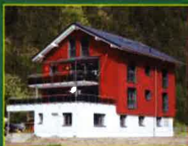
Neubau, 2 Familien-Haus in Schattdorf
