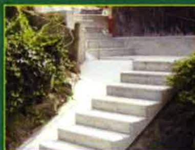
Umgebungsarbeiten in Amsteg
